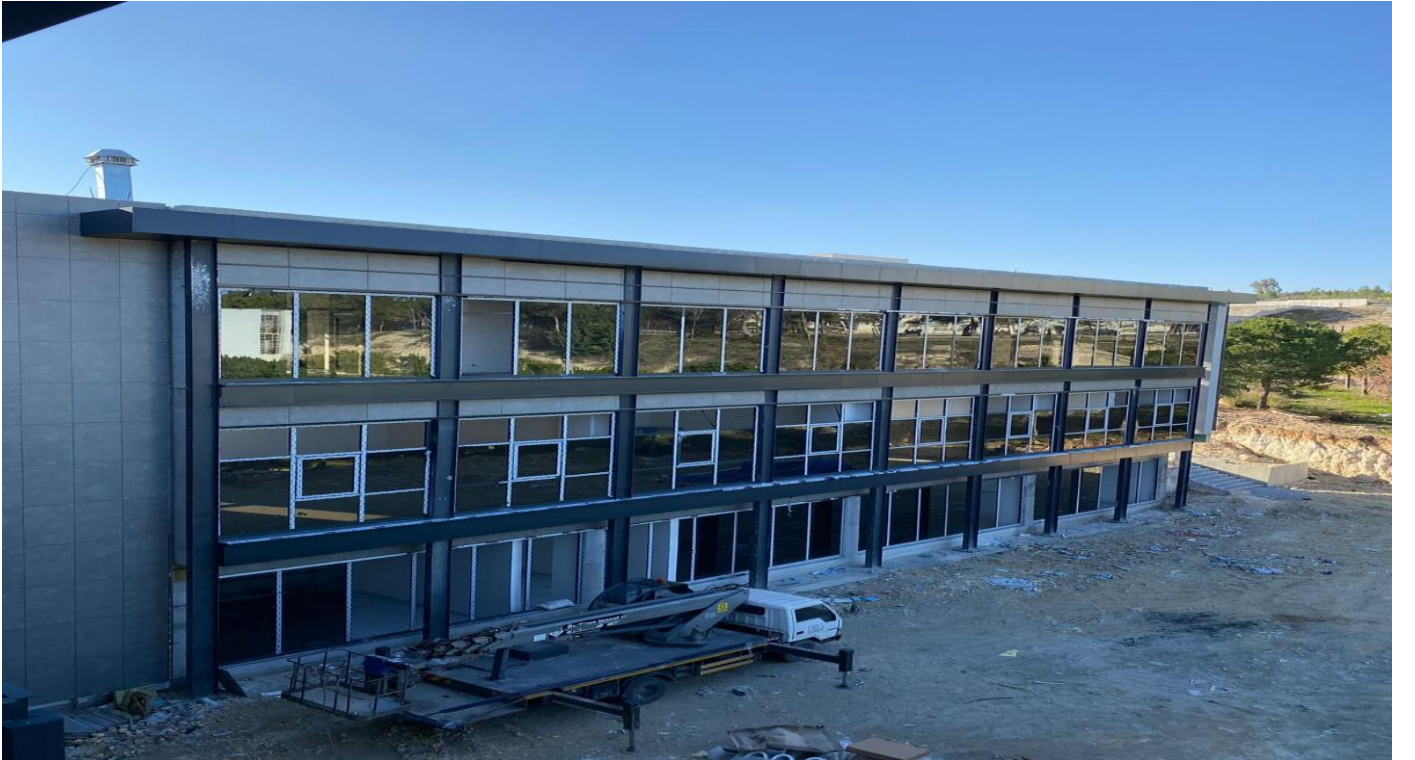
Tarsus Üniversitesi Kütüphane Binası İnşaatı
