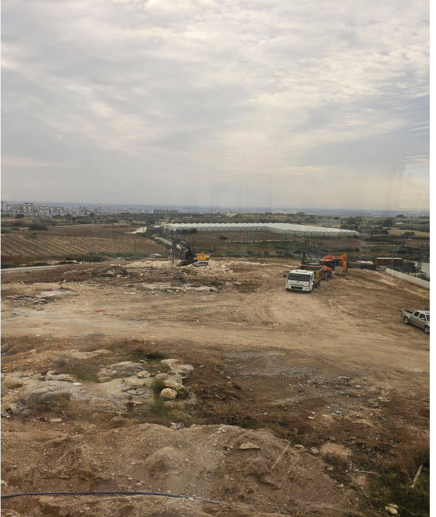
Merkezi Derslik Binası İnşaatı
