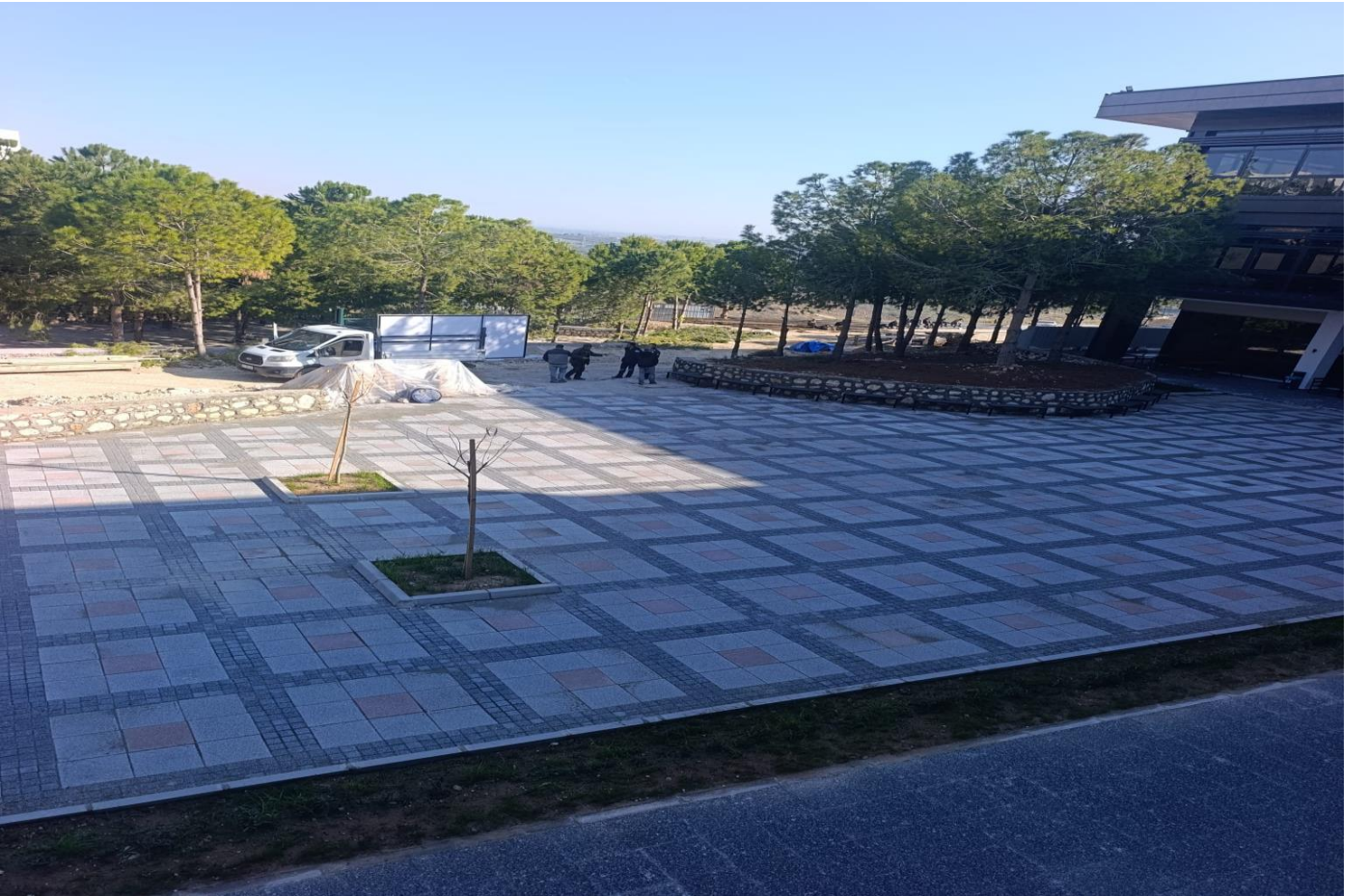
Çevre Düzenlenmesi ve Sınır Çiti Yapılması İşi
