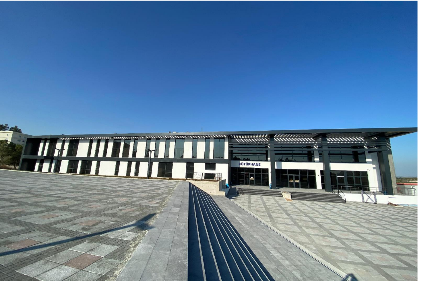
Tarsus Üniversitesi Kütüphane Binası İnşaatı
