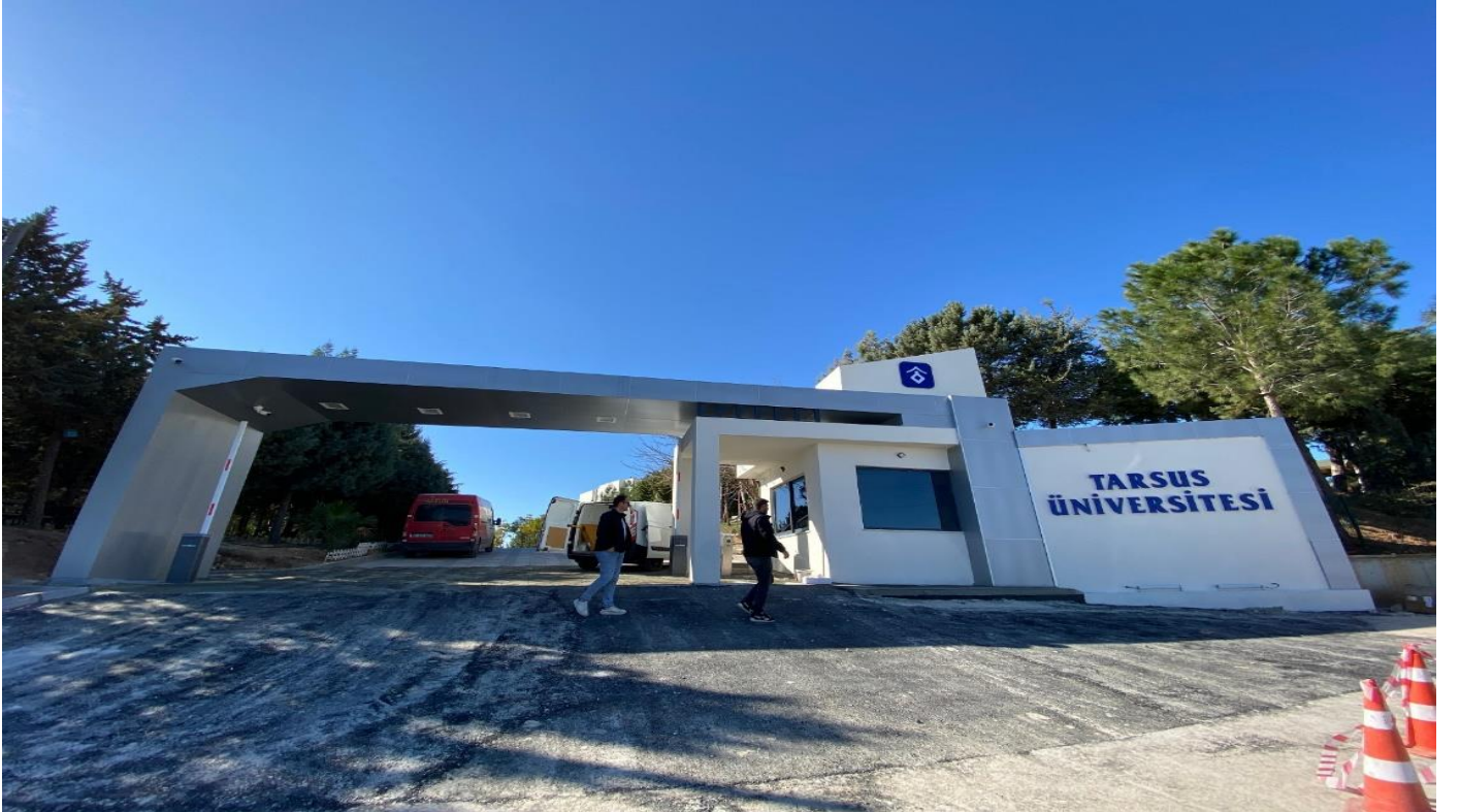
Giriş Kapısı ve Genel Çevre Düzenleme İşi
