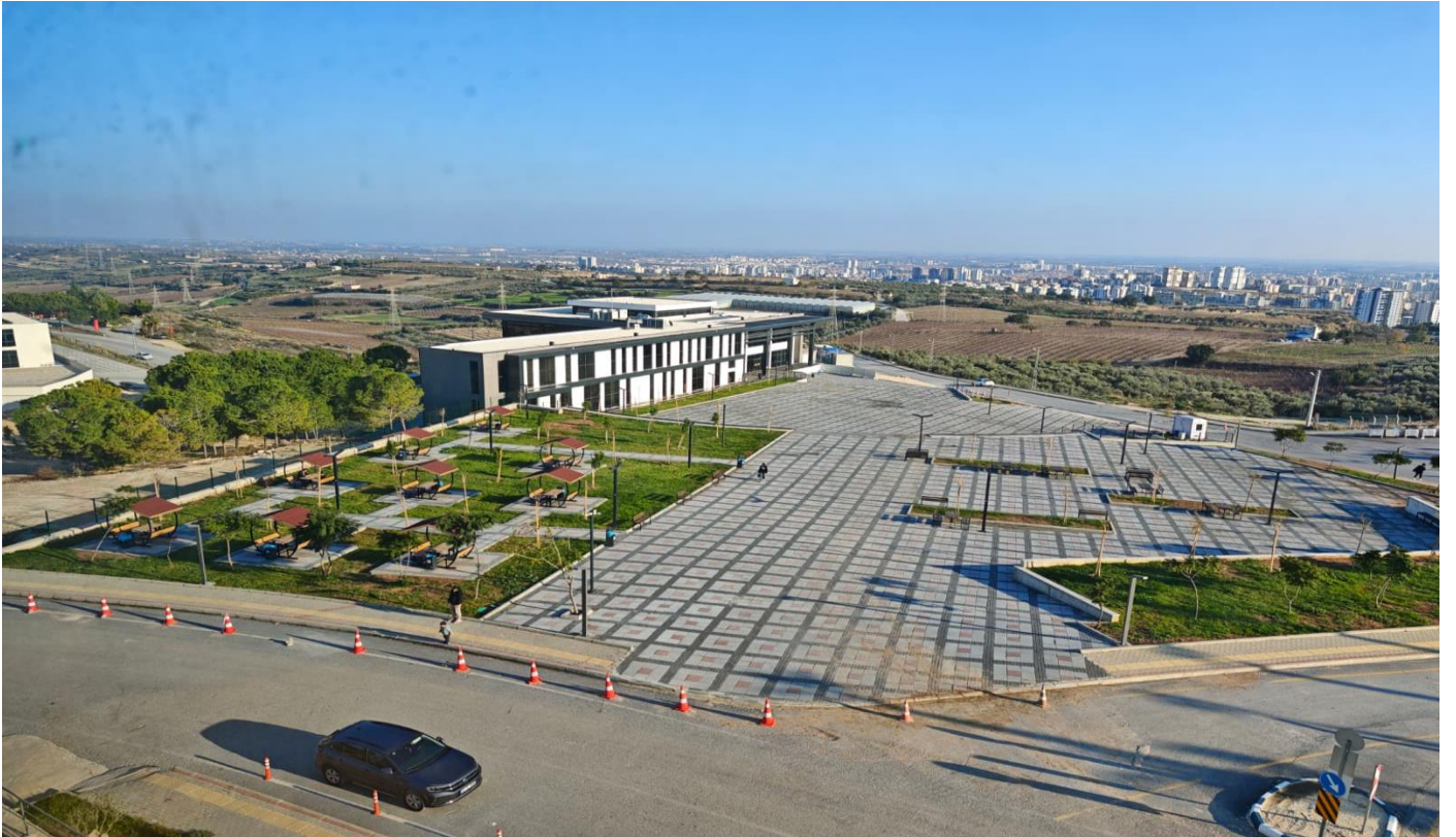
Çevre Düzenlenmesi ve Sınır Çiti Yapılması İşi
