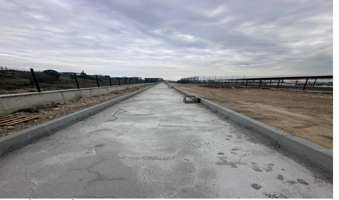
Muhtelif İnşaat Yapım İşi
