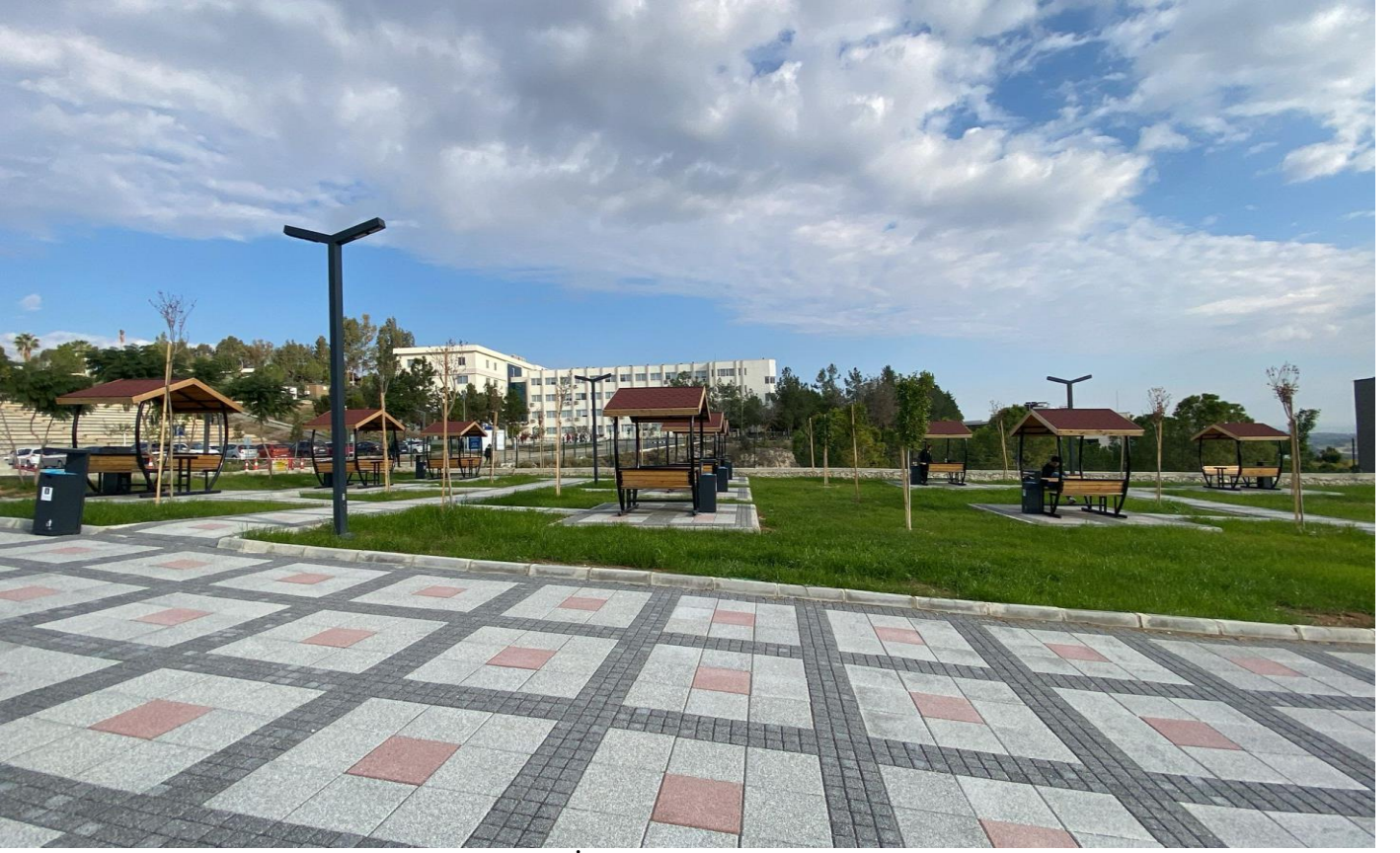
Çevre Düzenlenmesi ve Sınır Çiti Yapılması İşi
