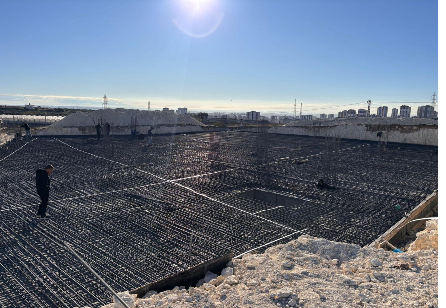
Merkezi Derslik Binası İnşaatı
