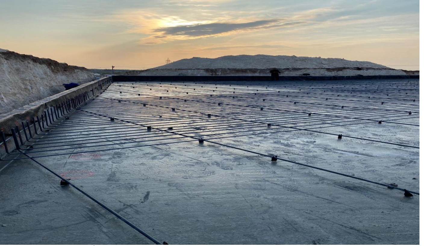
Merkezi Derslik Binası İnşaatı
