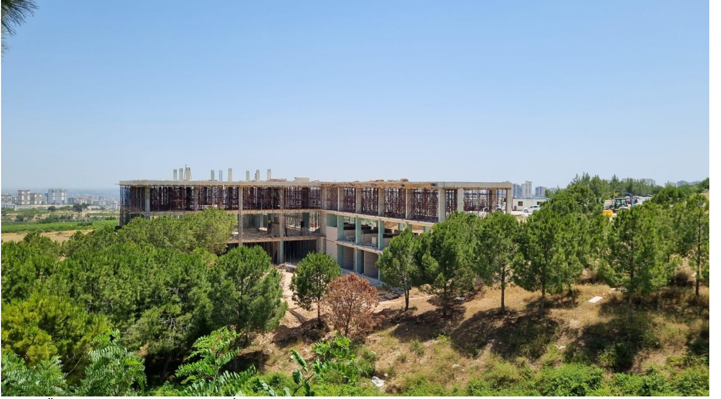
Tarsus Üniversitesi Kütüphane Binası İnşaatı
