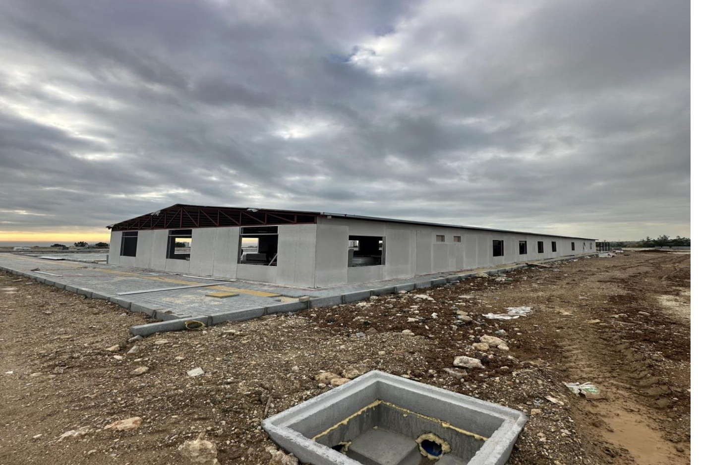
Muhtelif İnşaat Yapım İşi
