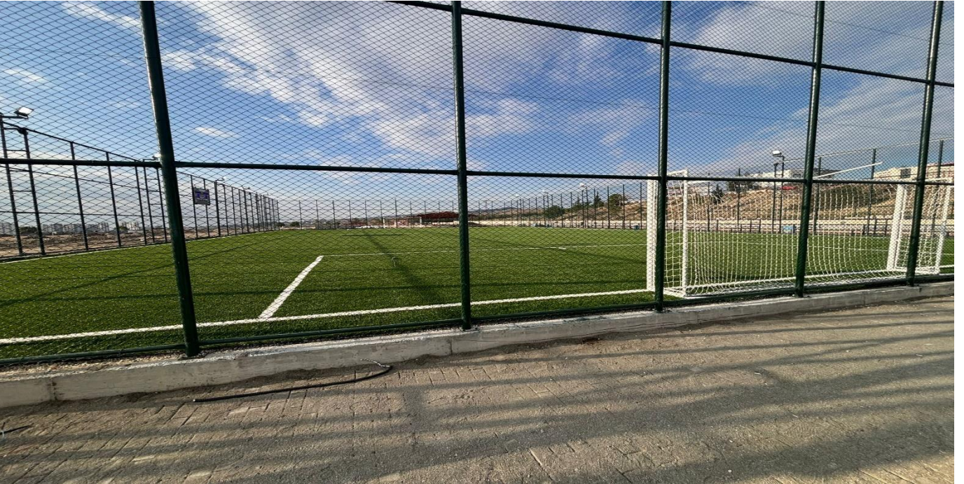
Merkez Kampüs Halı Saha ve Soyunma Odası Yapım İşi
