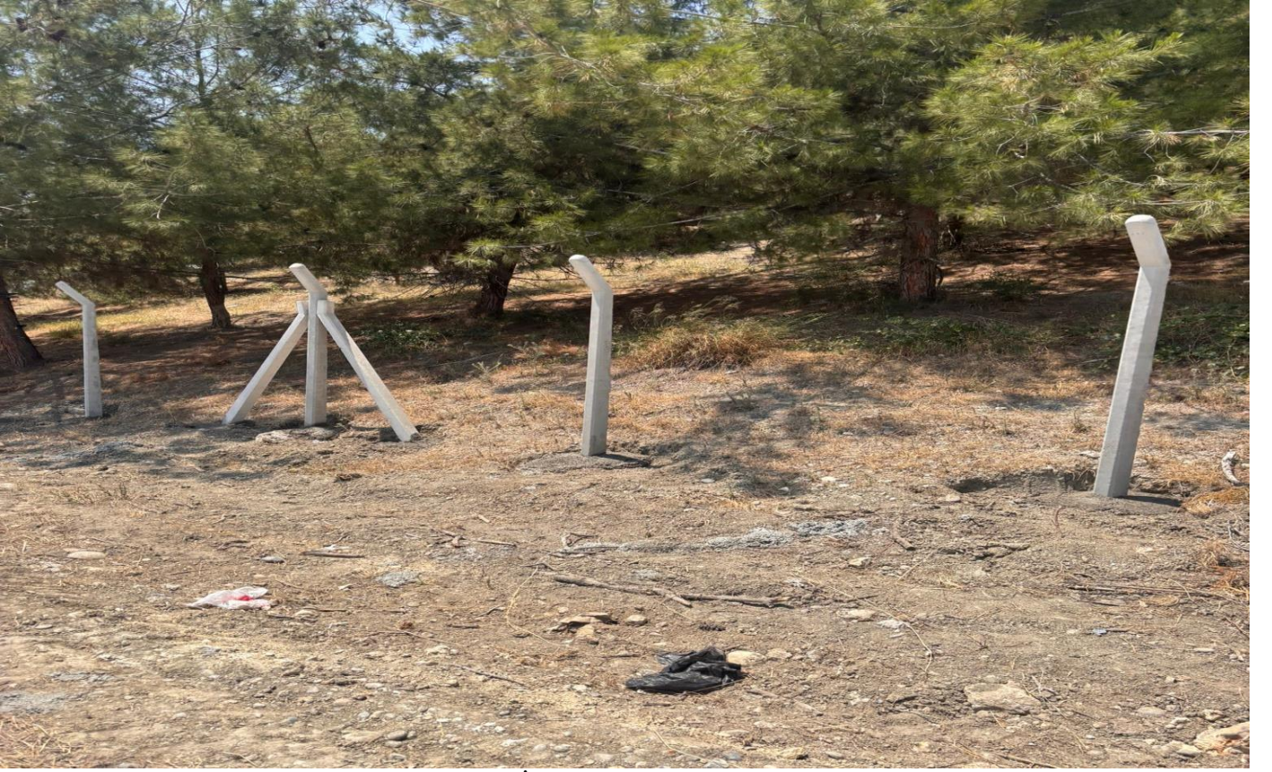
Çevre Düzenlenmesi ve Sınır Çiti Yapılması İşi
