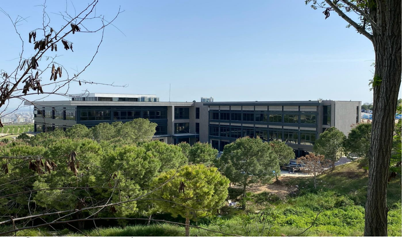
Tarsus Üniversitesi Kütüphane Binası İnşaatı
