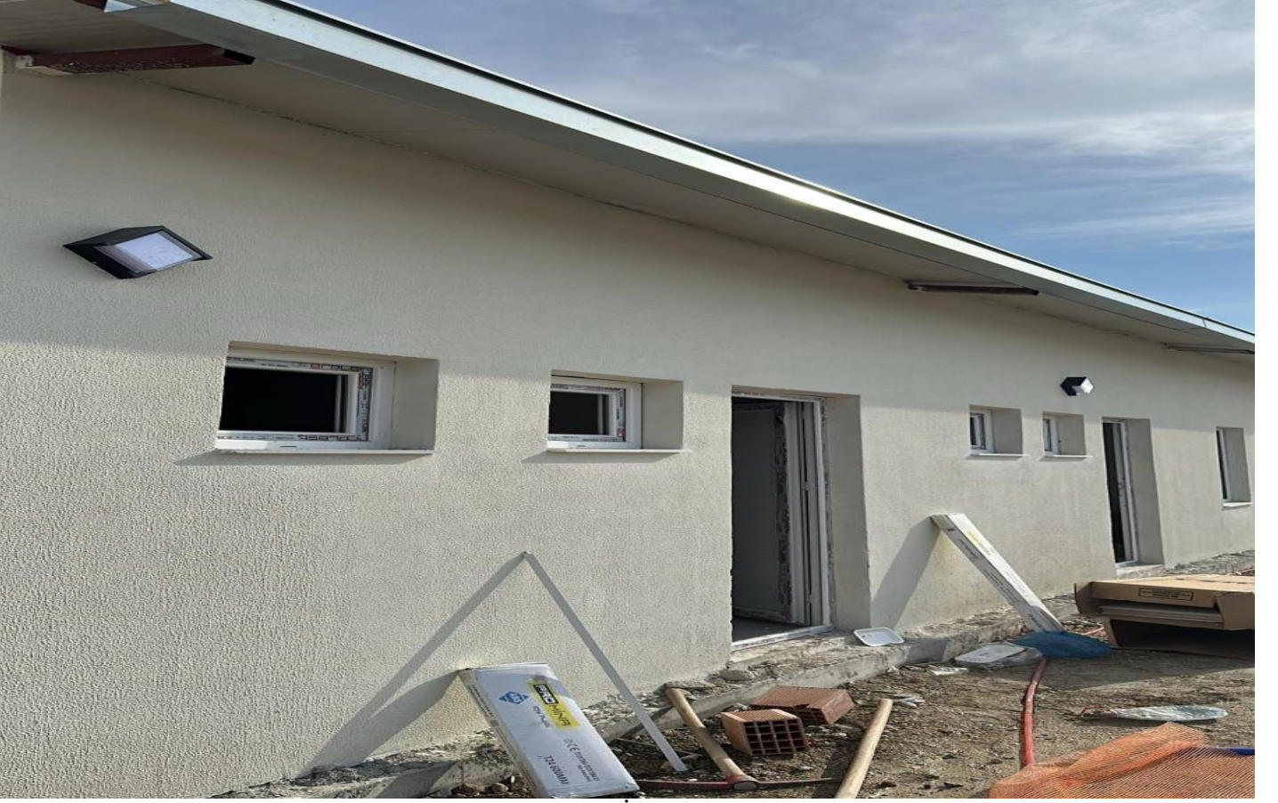
Merkez Kampüs Halı Saha ve Soyunma Odası Yapım İşi
