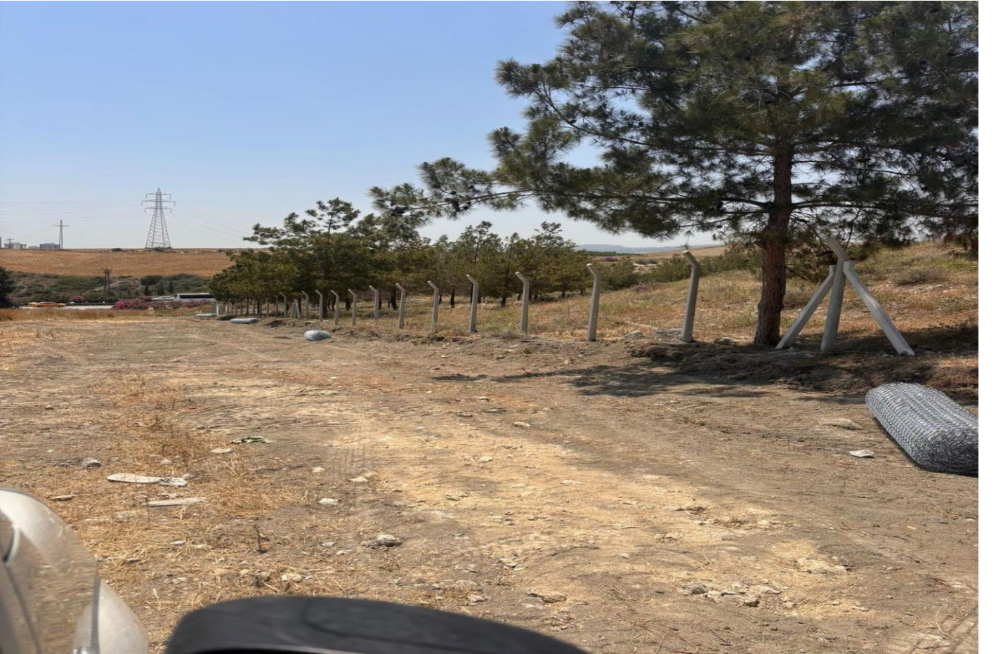
Çevre Düzenlenmesi ve Sınır Çiti Yapılması İşi
